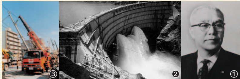
① 初代社長の太田垣士郎 ② 完成間近の黒部ダム（1963年6月・黒部川第四発電所竣工） ③ 阪神・淡路大震災時の復旧作業（1995年） ④ 営業運転を開始した堺太陽光発電所（2011年9月）
