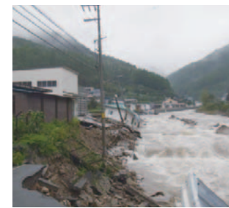
川の氾濫で切断された配電設備(上) 設備復旧のようす(右)
