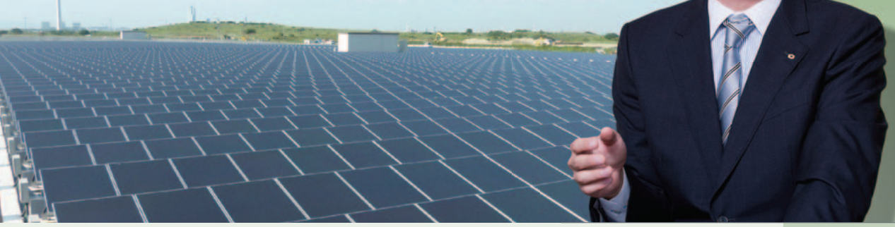
甲子園球場の約5倍にあたる21haの敷地に約7万4,000枚の太陽電池モジュールを敷き詰めた堺太陽光発電所
