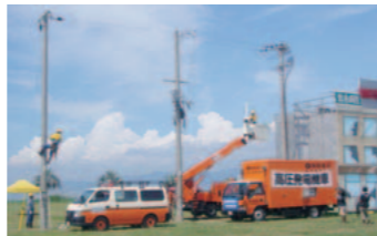
自治体主催の防災訓練で配電線の復旧作業を公表
