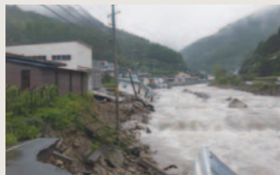
川の氾濫で切断された配電設備
