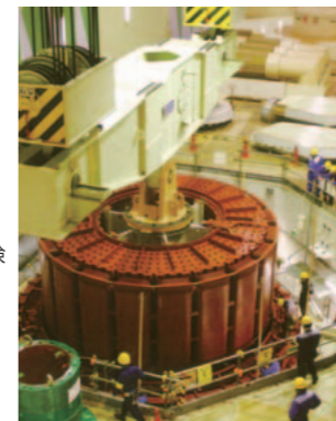
水力発電所の点検
