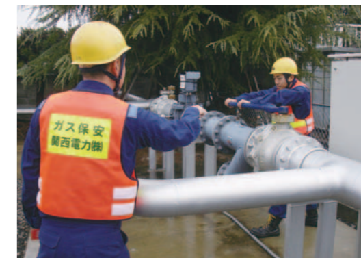
緊急時のガス供給弁閉止の訓練
