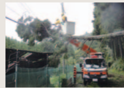
設備復旧のようす
