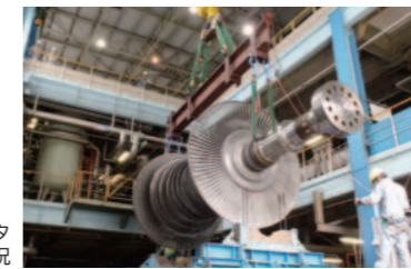
低圧タービンロータ点検後の搬入状況
