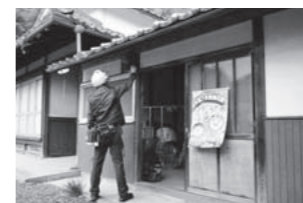
高齢者宅の電気設備点検
