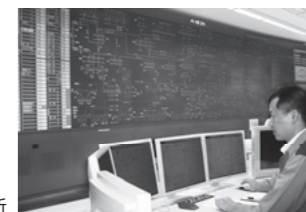
基幹系統給電所
