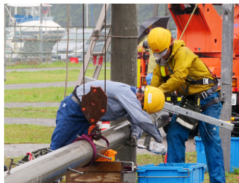
災害時に備えた復旧作業訓練
