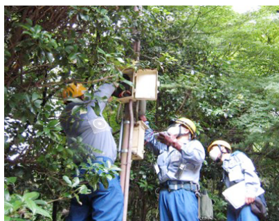
書寫山 圓教寺での電気設備点検
