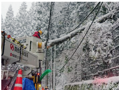
倒木により断線した電線の復旧
