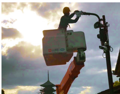
東寺での照明設備の清掃
