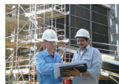
●セノコ発電所でのリパワリング工事
