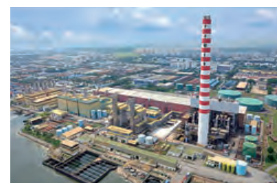
●シンガポールセノコ火力発電所
