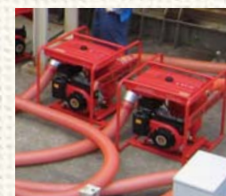
エンジン駆動海水ポンプを各発電所に計70台設置
