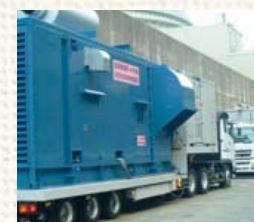
空冷式非常用発電装置を各発電所の高台に計21台設置
