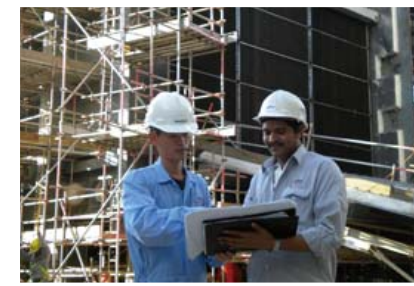
●セノコ発電所でのリパリング工事
