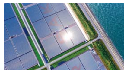
●堺太陽光発電所
