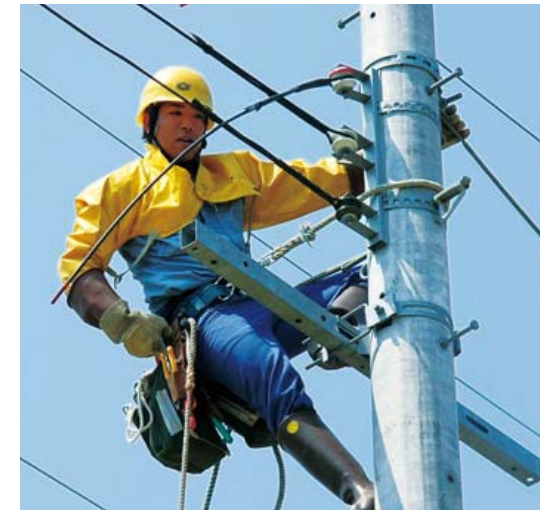
●配電線のメンテナンス
