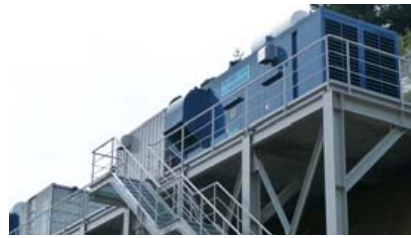
●空冷式非常用発電装置
