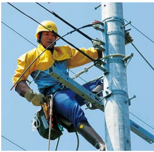
●配電線のメンテナンス
