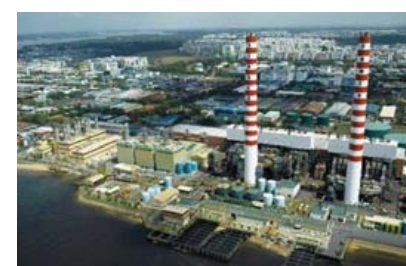
●シンガポールセノコ火力発電所
