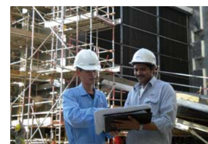
●セノコ発電所でのリパリング工事
