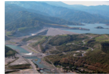
●サンロケ水力発電所
