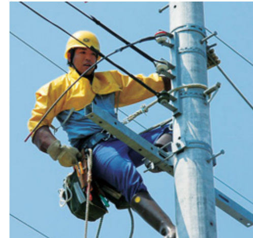
●配電線のメンテナンス
