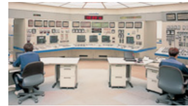
●原子力発電所中央制御室
