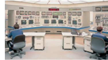
●原子力発電所中央制御室
