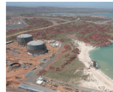
●ブルート建設現場
