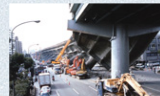
●倒壊した阪神高速道路
