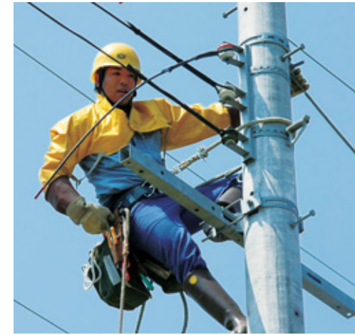
●配電線のメンテナンス
