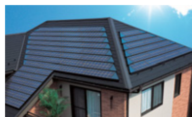
●屋根に設置した太陽電池モジュール
