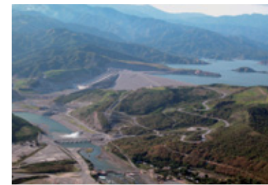
●サンロケ水力発電所
