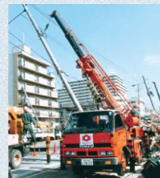
●阪神・淡路大震災時の復旧作業
