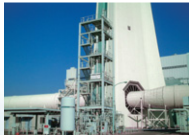
●南港発電所排煙脱炭プラント
