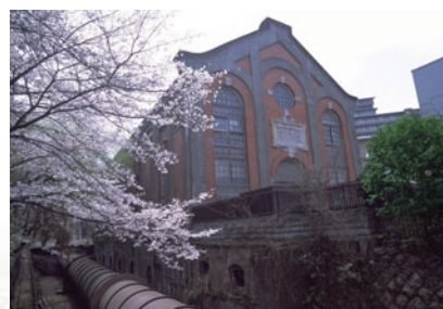
●蹴上発電所(旧館)と水圧鉄管
