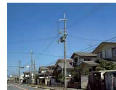
●電柱と変圧器
