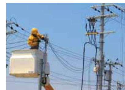
●配電線のメンテナンス
