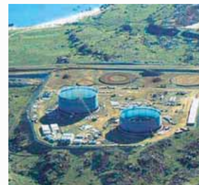
●LNG貯蔵タンクの建設現場(ブルートLNGプロジェクト)
