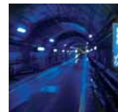
●破碎帯を貫く関電トンネル
