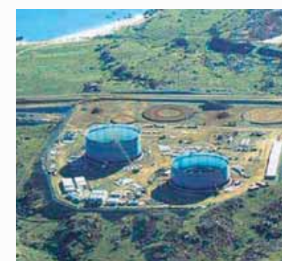
●LNG貯蔵タンクの建設現場 （ブルートLNGプロジェクト）
