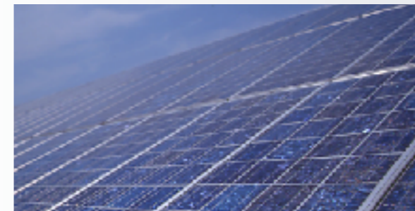
太陽光発電パネル（南港発電所）
