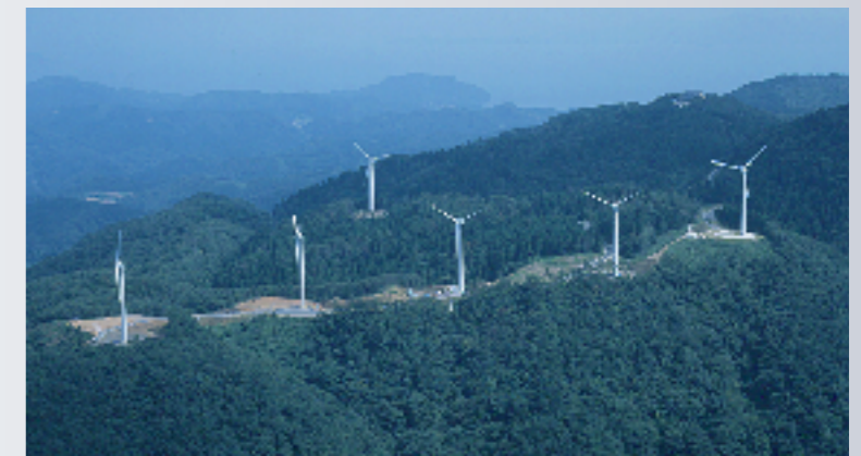
「関西グリーン電力基金」の助成による太鼓山風力発電所（事業主体・京都府）
