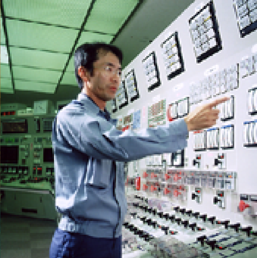
高浜発電所中央制御室
