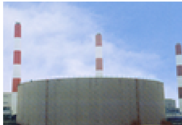
シンガポール / セラヤ第一火力発電所
