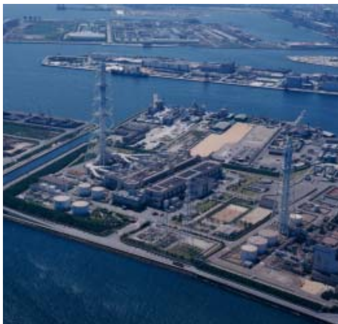
姫路第一発電所
