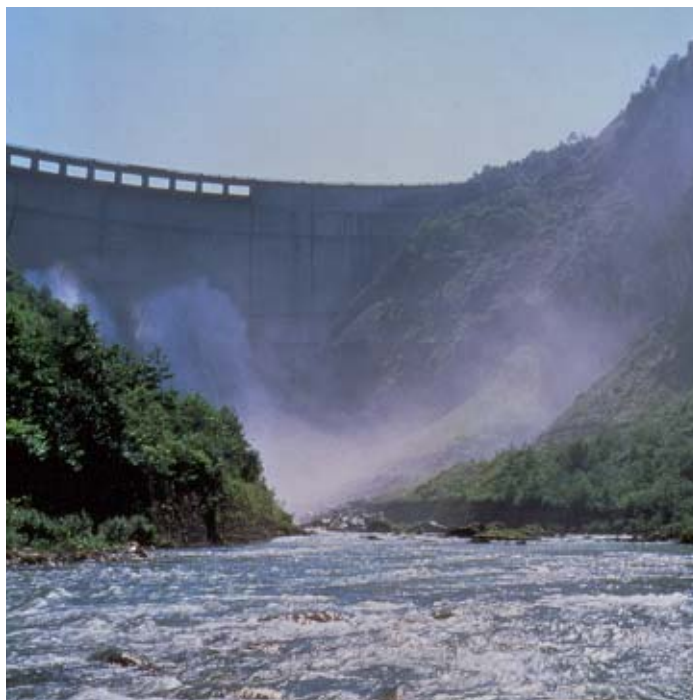
黒部川第四発電所
