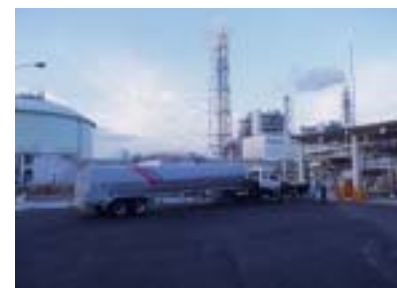
ローリーによるガス出荷（姫路LNG管理所）
