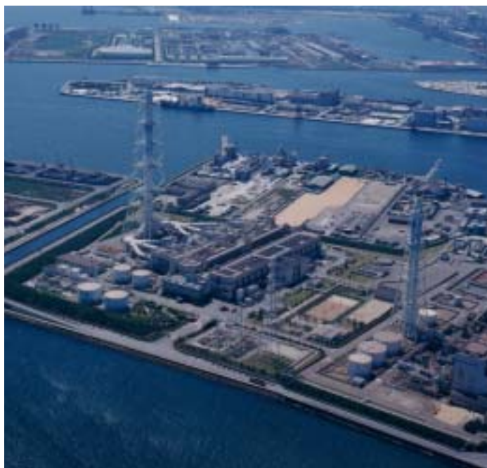
姫路第一発電所
