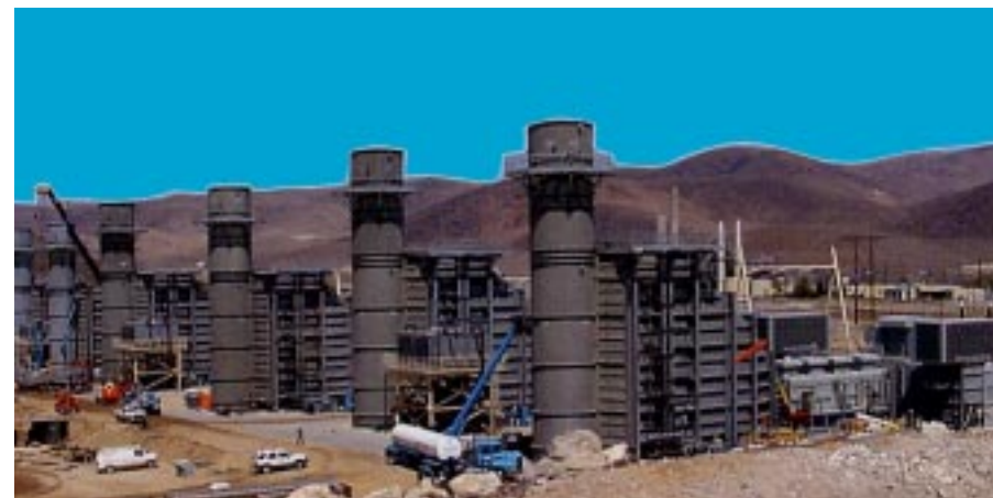
ガスタービン設置現場/米国ネバダ州
