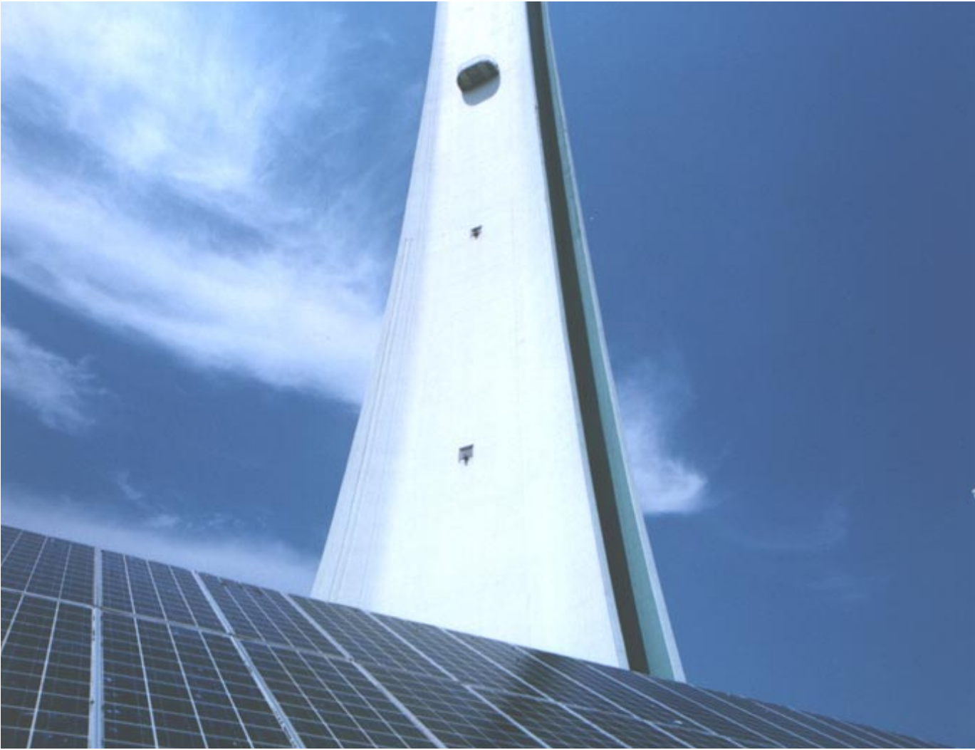
太陽光発電装置と美しいフォルムの煙突（南港発電所）
