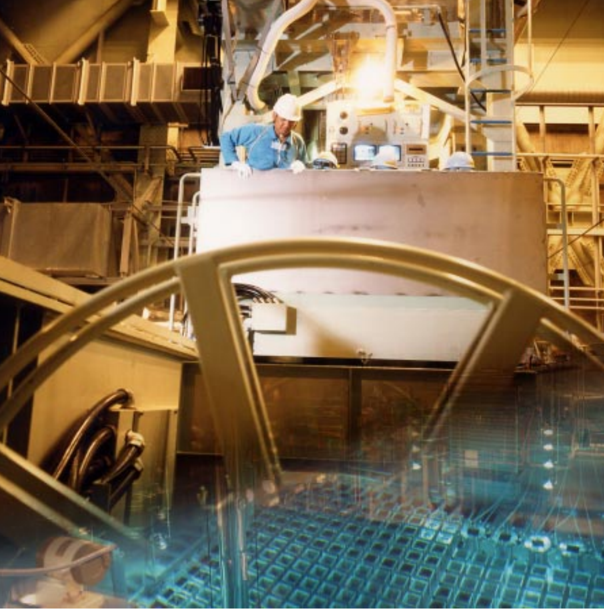
使用済燃料棒点検作業 (高浜発電所/原子力)
