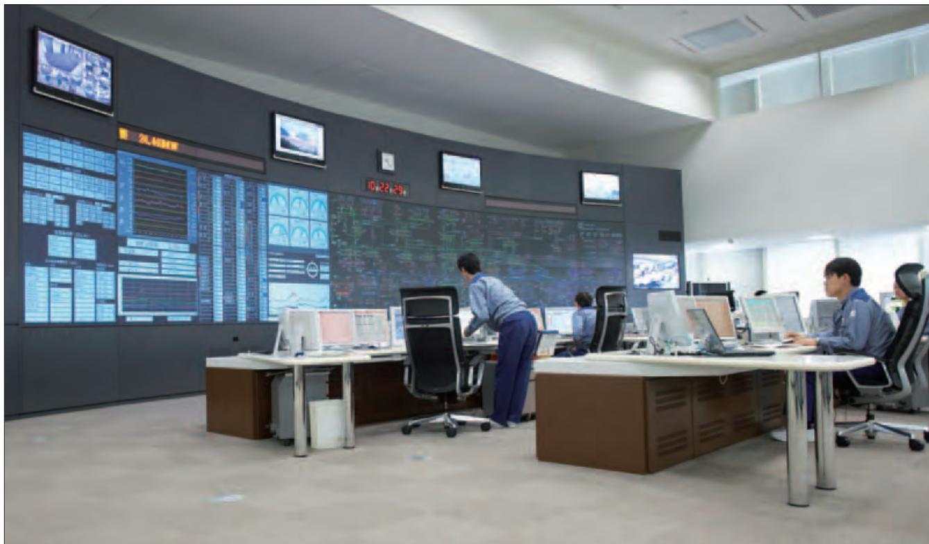
電力需要の変化を監視し、必要な発電量を各地の発電所に指示する「中央給電指令所」
