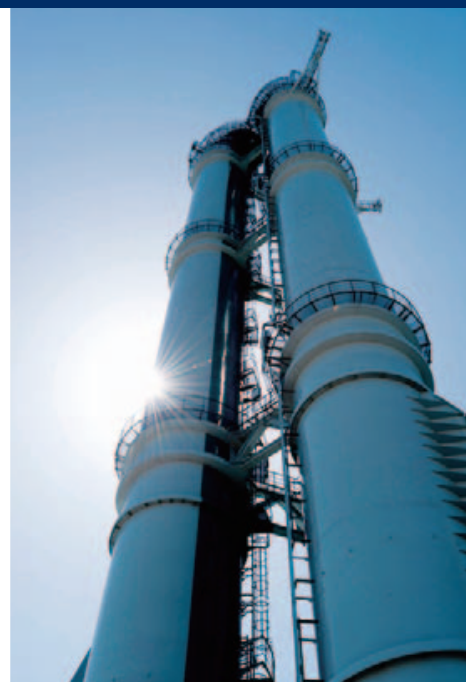
堺港火力発電所
