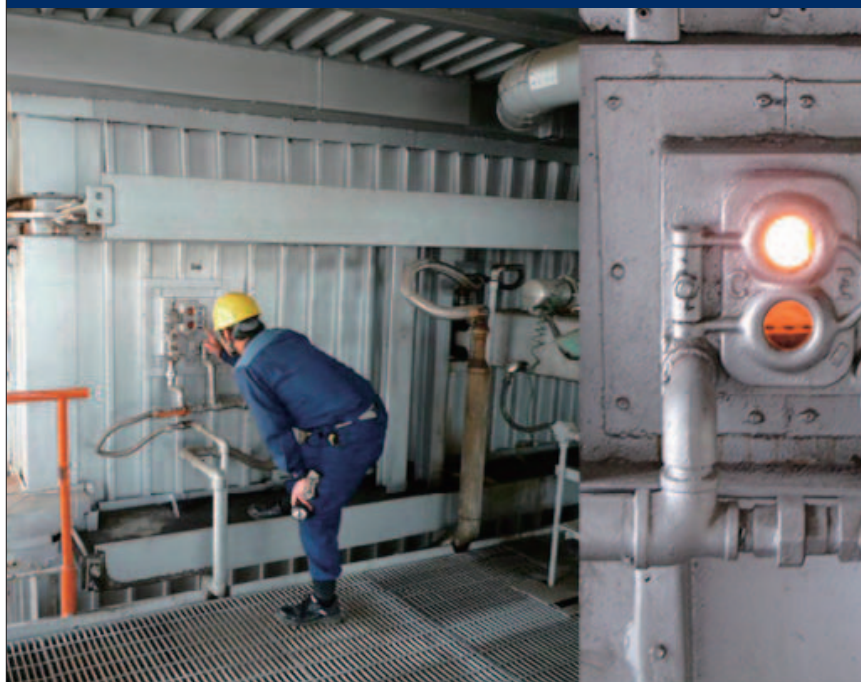
発電所のボイラーの点検作業
