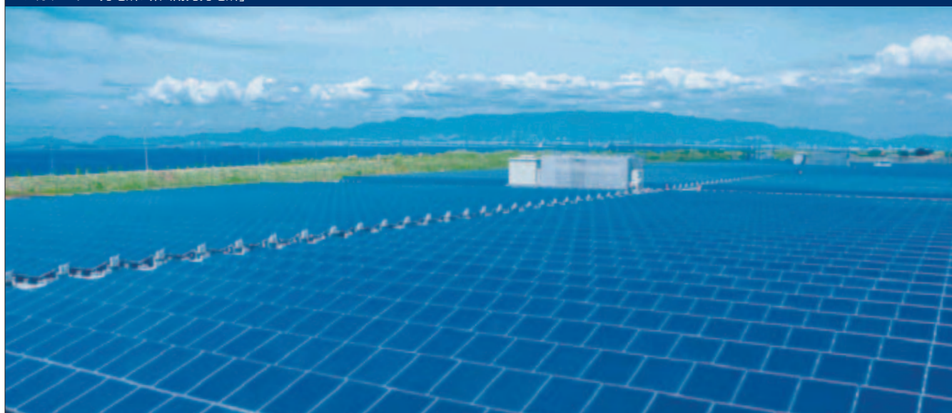
メガソーラー発電所「堺太陽光発電所」
