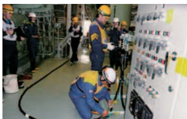
電源車の接続訓練
