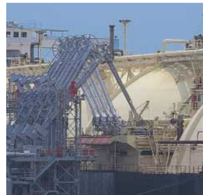
LNG ship and loading arm.
