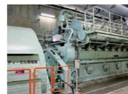
【非常用ディーゼル発電機(既設:4台/2ユニット)】
