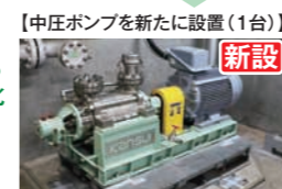
【中圧ポンプを新たに設置(1台)】
