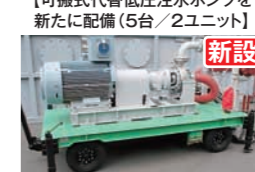
【可搬式代替低圧注水ポンプを新たに配備(5台/2ユニット)】
