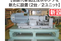
【恒設代替低圧注水ポンプを新たに設置(2台/2ユニット)】
