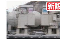
【海水ポンプモーター予備品を新たに確保(1台)】
