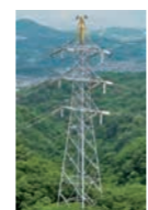
【外部電源(既設5回線)】
