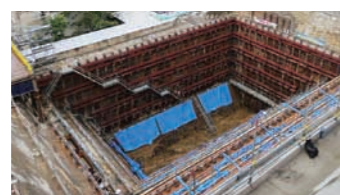
【発電所敷地内のトレンチ】
