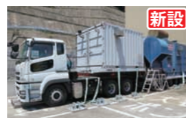
【空冷式非常用発電装置を新たに配備(4台/2ユニット)】
