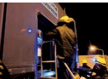
夜間における 接続・起動訓練
