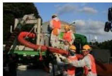
可搬式代替低圧注水ポンプ設置訓練
