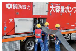
大容量ポンプ設置訓練
