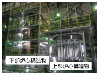
構造物各部件の工場組立完了 現地の干渉物撤去他施工中
