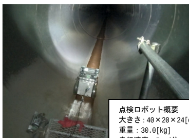
（2）：点検ロボットによる作業
