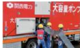
大容量ポンプ設置訓練
