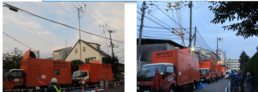
発電機車による応急送電の状況
