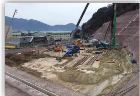
【高浜発電所緊急時対策所 建築工事】
