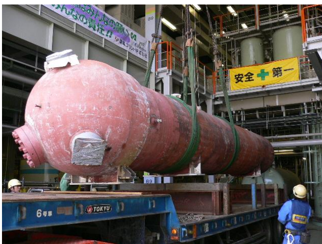
タービン建屋内機器解体 (平成29年度下期～) ※写真は過去の熱交換器取替工事
