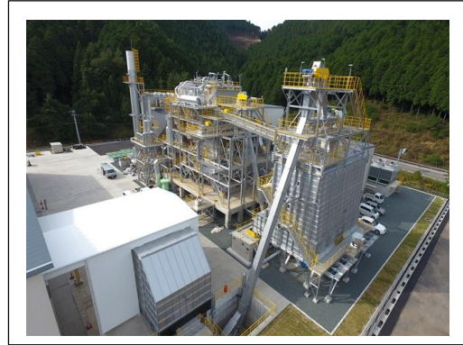
【朝来バイオマス発電所】
