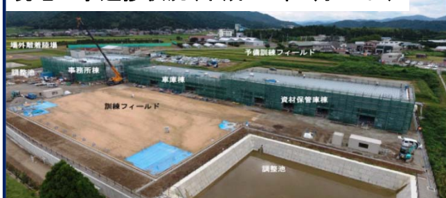
現地工事進捗状況(平成28年9月27日)
