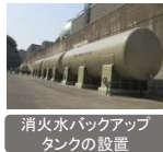
消火水バックアップタンクの設置
