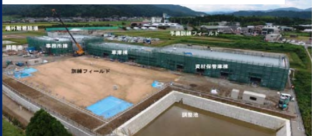
現地工事進捗状況(平成28年9月27日)
