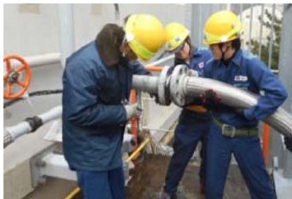
蒸気発生器への給水訓練の様子
