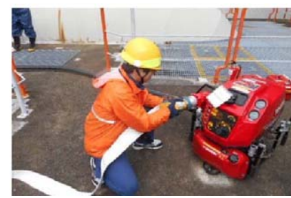
蒸気発生器への給水訓練の様子
