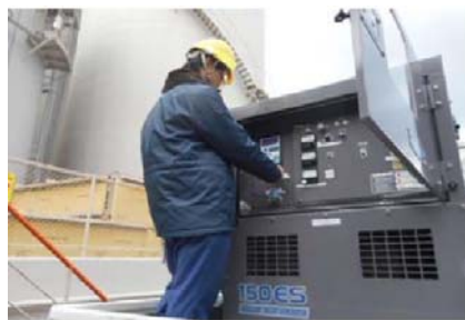
蒸気発生器への給水訓練の様子
