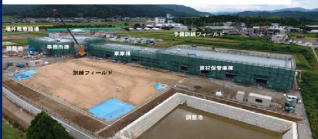
現地工事進捗状況(平成28年9月27日)
