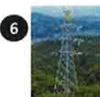
外部電源 (既設5回線)
