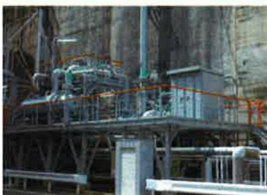
②天然ガス減圧設備新設
