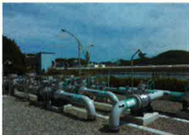
①天然ガス受入設備新設
