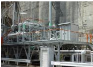
②天然ガス減圧設備新設
