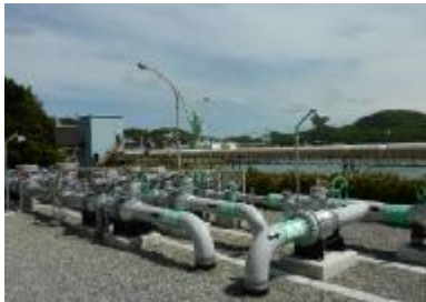
①天然ガス受入設備新設
