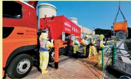
取水用水中ポンプ設置の様子
