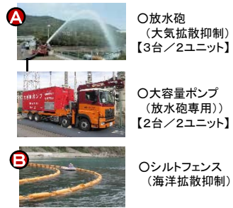
○シルトフェンス(海洋拡散抑制)
