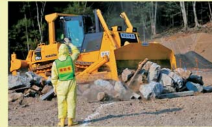
がれき撤去訓練の様子
