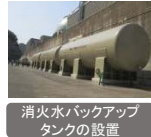
消火水バックアップタンクの設置
