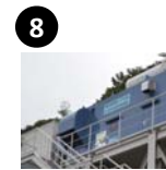
空冷式非常用発電装置【2台】
