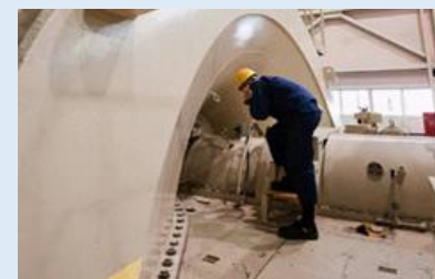
蒸気タービンの巡視 (姫路第二発電所)
