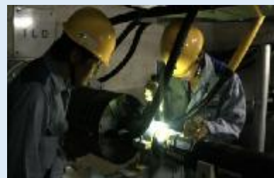
地中ケーブルの巡視 (由良開閉所)
