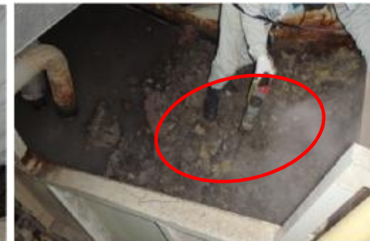
削岩機による灰の塊の破碎作業
