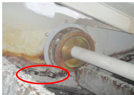
設備点検結果 (チェーン弛み発見)
