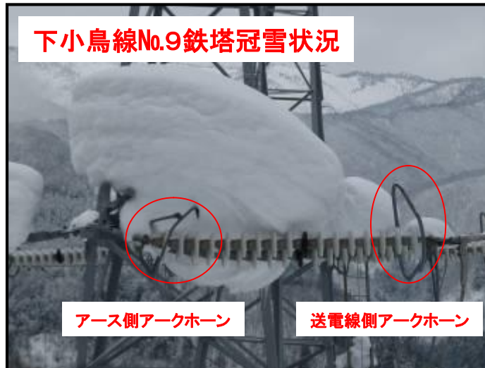
下小鳥線No.9 アース側アークホーン
